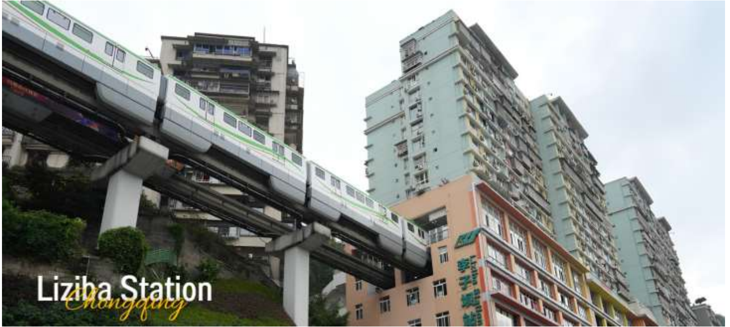
รถไฟทะลุตึก (Liziba Station)
