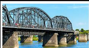
สะพานหวาดถานตง
